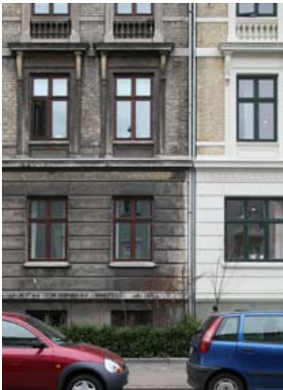
Facaden til venstre har en autentisk, men tilsodet stoflighed. På facaden til højre har de cementpudsede bygningsdele fået en malerbehandling - og en forsk stoflighed.
