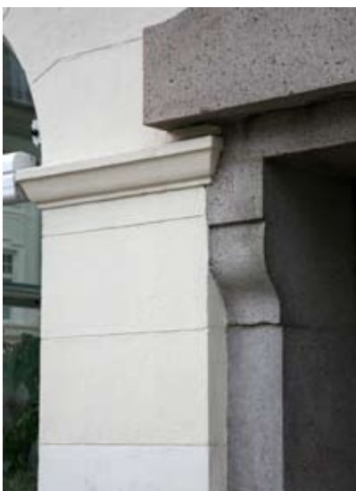
Den cementstøbte portal (med tilslag) fremstår med sin oprindelige stoflighed. Det gør det tilstødende kvadernurværk ikke, da det har fået en malerbehandling.
