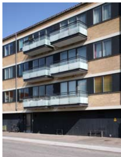
Facaderenoveringen er tilpasset det oprindelige udtryk.
