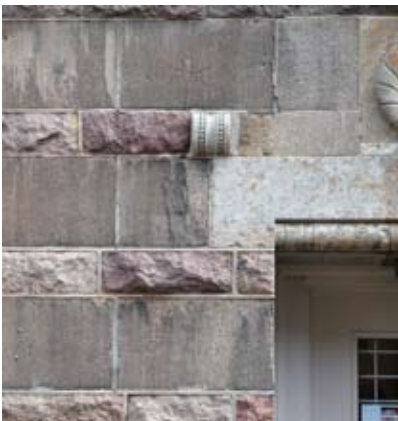
Kontraster mellem kløvet granit og riflede cementblokke.
