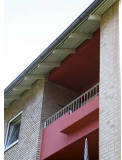
Synlige spærender og udhængsbrædder, blankt murværk, malerbehandlet cementbrystning og hvidmalet stålrækværk er eksempler på stilartens glæde ved håndværk, enkelhed og rustik stoflighed.
