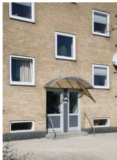
Halvtag i akryl og døre med aluminiumsrammer og -fyldninger er fremmede for stilarten.
