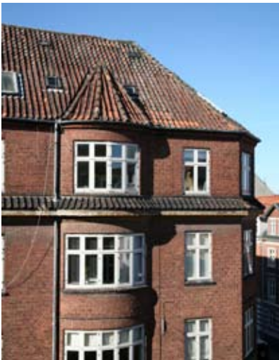
Mansardetagen blev afsluttet med et regulært sadeltag, en ubrudt flade.
