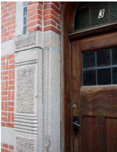
Dørindramning med mønstermurværk og fint tilhugget granit.
