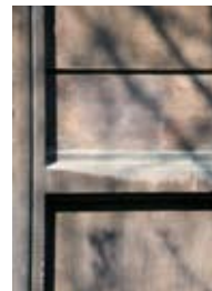
Nærbillede af en facadereparation med indfarvet mørtel.
