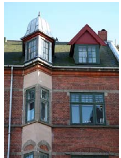
Nationalromantisk glæde ved uortodokse bygningsdetaljer: Den trekantede karnap afsluttes i taghøjde med et klokkeformet zinktæg.
