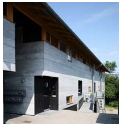
Fem Fingre/Fagbo, Ladefogedvej 2-84, Skejby (1993, 2000 af Tegnestuen Vandkunsten) Vellykkede eksempler på anvendelse af byggeplader som facademateriale. Detaljerne er elegante og gennemarbejdede. Eternitpladerne har her fået en smuk patinerung.
