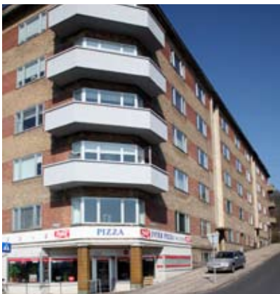
De stofflige kvaliteter forsvinder, når altanernes indfarvede pudslader malerbehandles, eller når altaner indpakkes i profilerede stål-plader:
