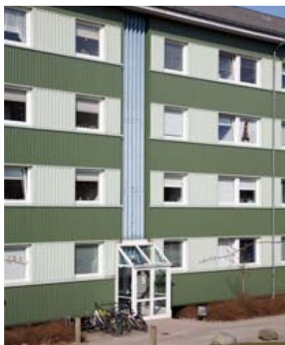
Facaderne er efterisolerede og beklædt med profilerede stålplader - kulissearkitektur.
