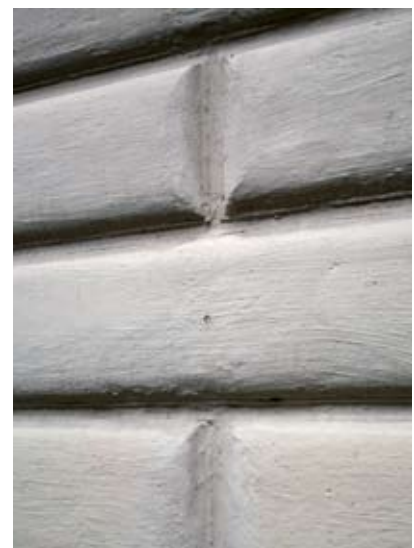
Kvadernurværket er behandlet med tyndpuds, og den grødagtige overflade slører konturerne.
