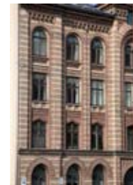
Rundbuestil: Vodroffsvej 3, Frederiksberg (1868).
