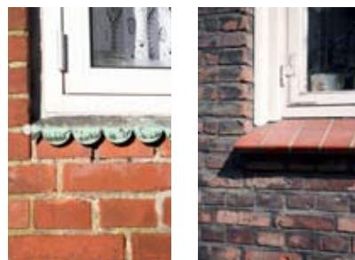
Trævinduer med sålbænke af kobber eller glaserede tegl - gode eksempler:
