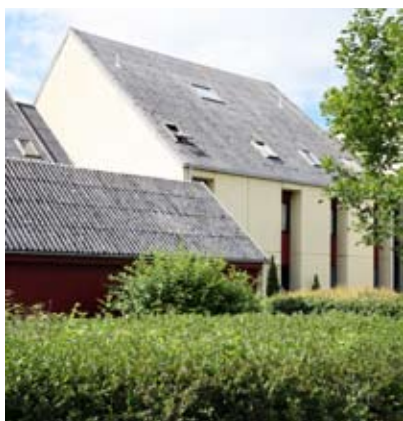
Patinerung. Bølgeeternitten er modtagelig for alger og snavs. Facadens betonelementer er "shinet up" med maling.
